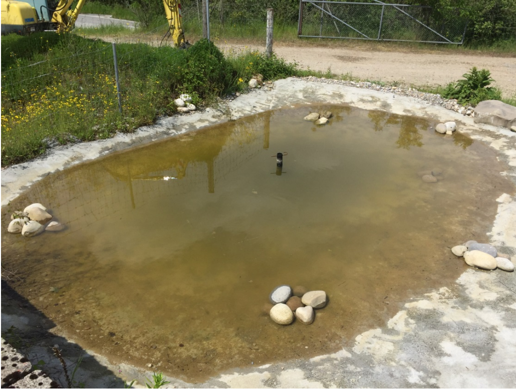
Folien-Betonweiher mit Grundablass für Kreuzkröten in Berken
