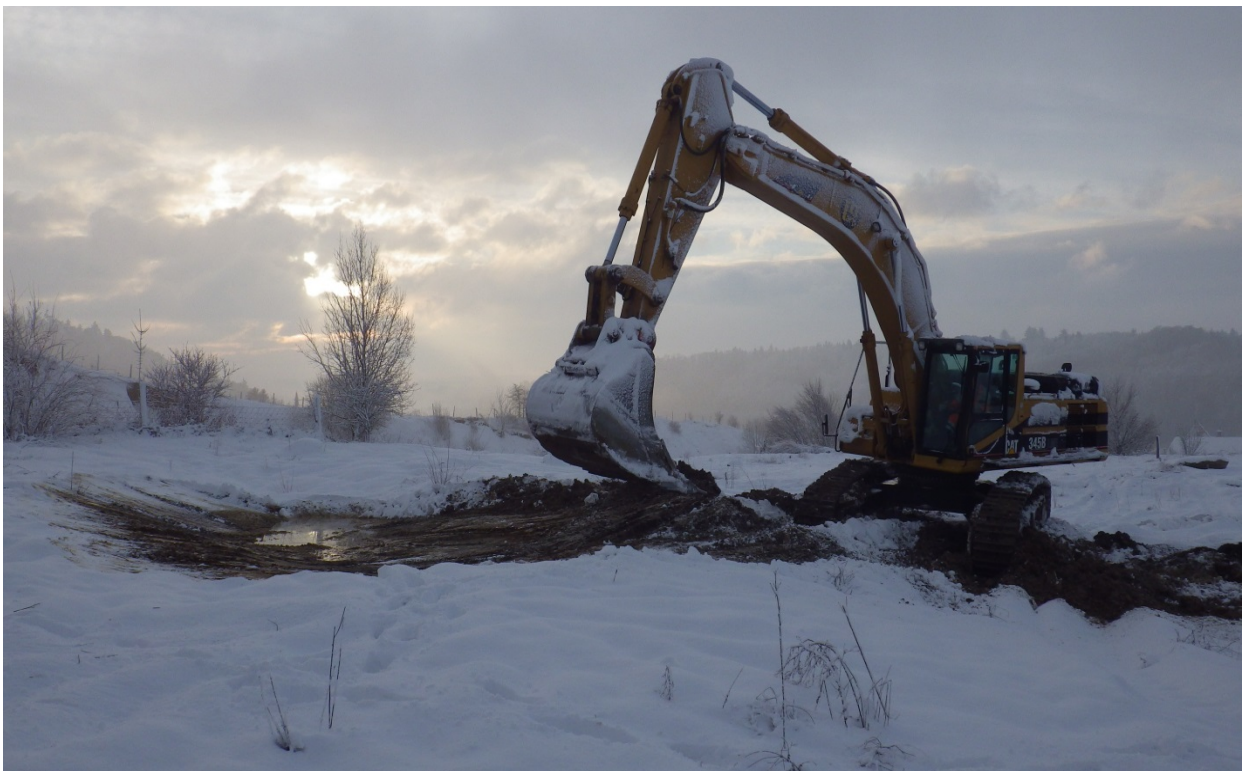
Abb. 3: Unter Anleitung eines Mitarbeiters der SL&K erstellt ein Maschinist ein neues Laichgewässer für die Kreuzkröte.
