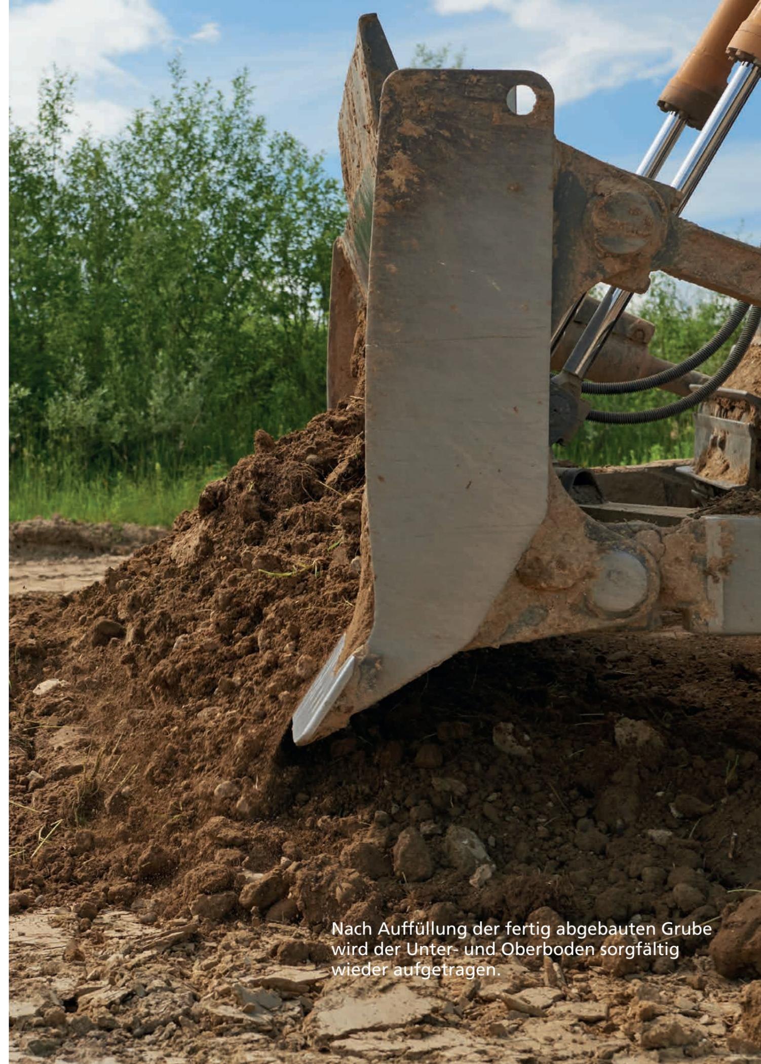
Nach Auffüllung der fertig abgebauten Grube wird der Unter- und Oberboden sorgfältig wieder aufgetragen.
