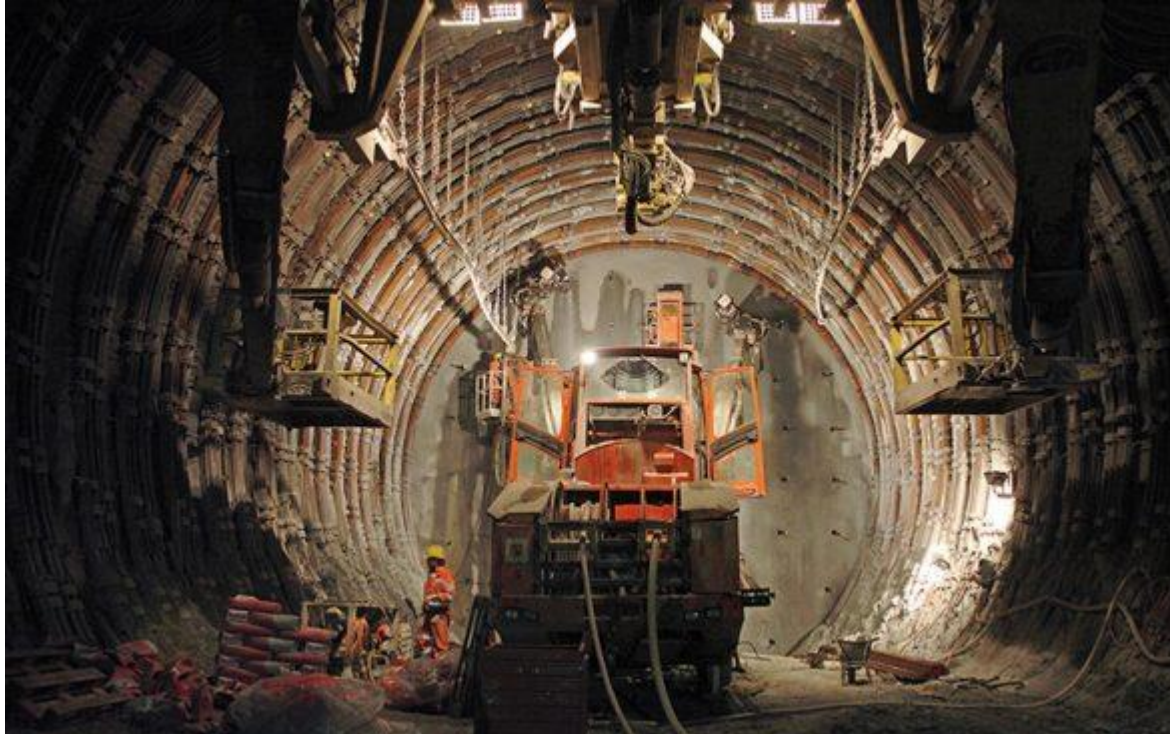
Bauarbeit im Gotthard-Basistunnel © AlpTransit Gotthard AG
